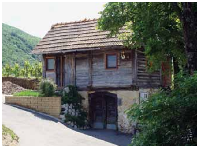
Obnovljeni »podkleteni hram« iz vzhodnega dela Gadove peči. A refurbished cellared cottage located in the eastern part of Gadova peč. (foto: D. Ivanšek)
